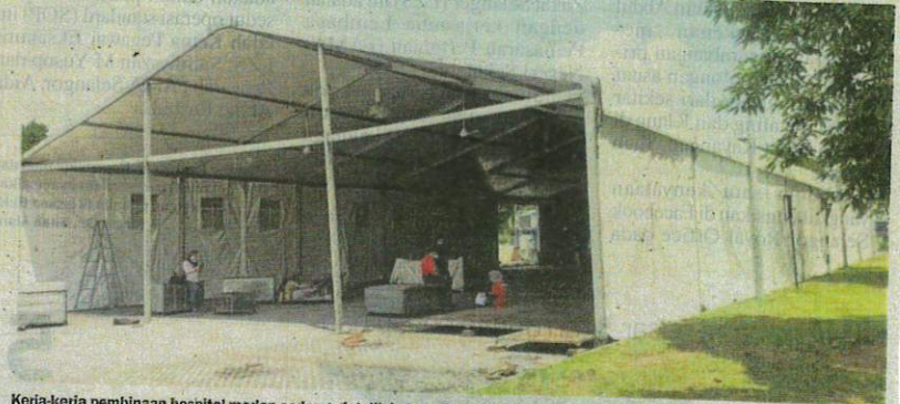
Kerja-kerja pembinaan hospital medan sedang giat dilakukan di HTAR, Klang.
